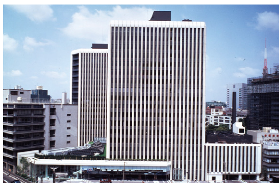
●赤坂ツインタワー
