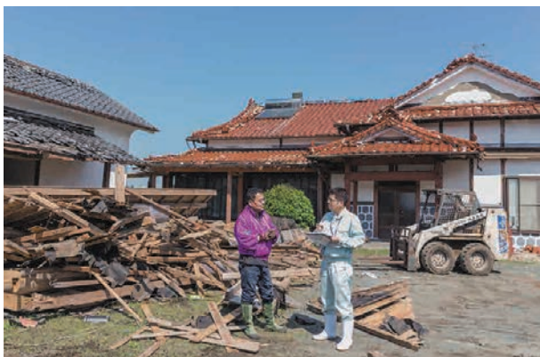
自然災害時の損害調査の様子
