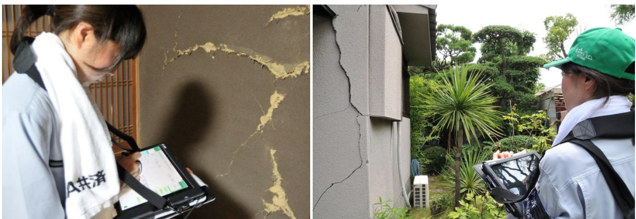
被災家屋を一軒一軒訪問し損害調査を行なう様子
