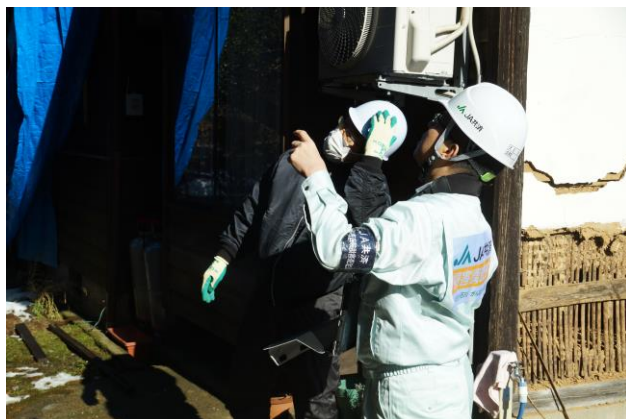
損害調査の様子
