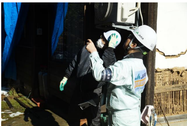
損害調査の様子
