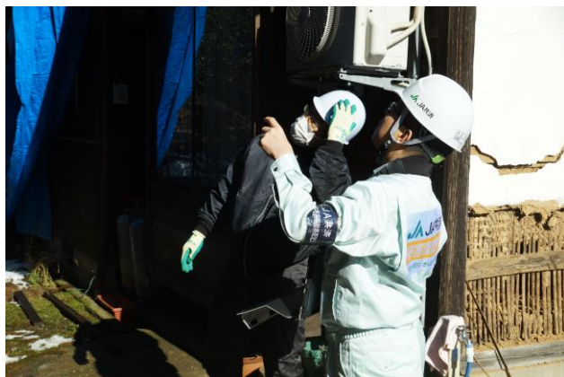
損害調査の様子
